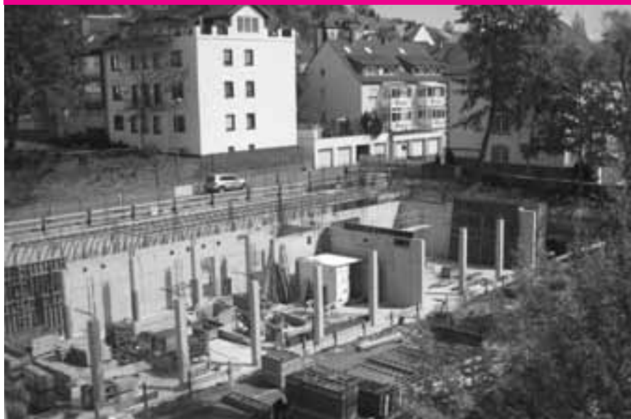
Der neue Gebäudeteil am Benzinoring wächst täglich.
