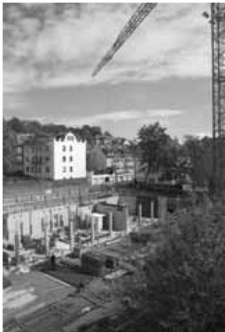
Kann man täglich wachsen sehen: das Untergeschoss des Gebäudeneubaus am Benzinoring.
