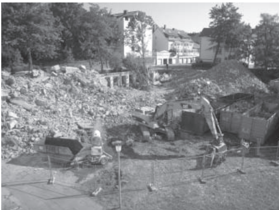
Während des laufenden Schulbetriebs dem Erdboden gleichgemacht: der Gebäudeteil Benzinoring der BBS II.
