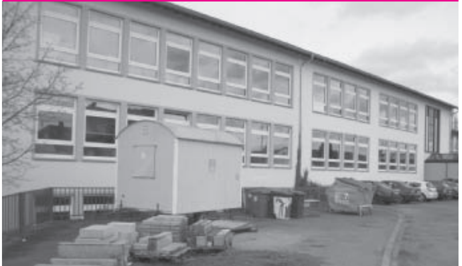
Ein Teil des Gebäudes der Münchhofschule in Hochspeyer wird für zweieinhalb Jahre Klassen der Abt. I aufnehmen. Fotos: Vorderansicht (oben) und Rückansicht (unten).
