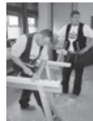
... und im Zimmermannshandwerk.
